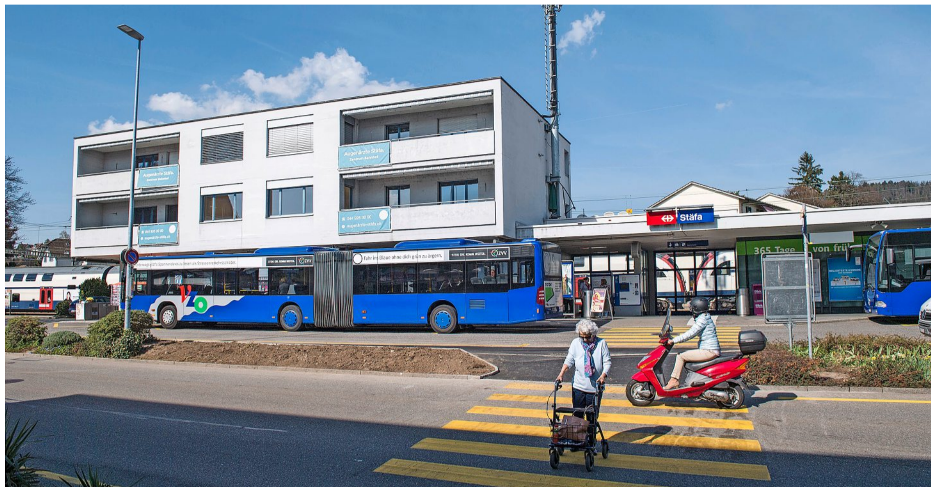
Der Bahnhof Stäfa wird ab 2026 hindernisfrei ausgebaut. Archivfoto: Michael Trost
